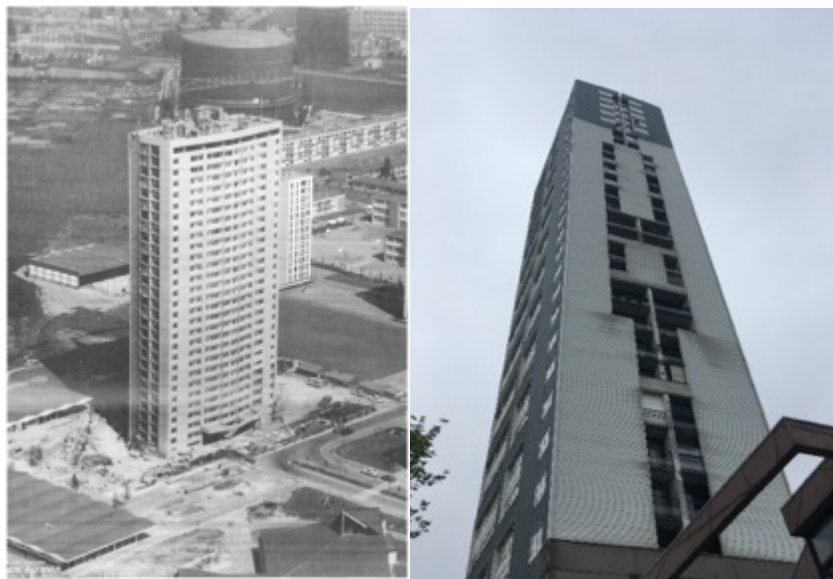
Tour Kennedy lors de sa construction et aujourd'hui (réhabilitation en 1996)
