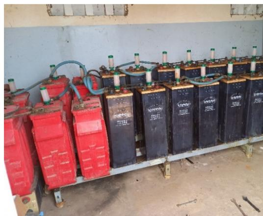
**Photo 3 : Batteries de la mini-centrale. Certaines ne fonctionnent plus et ont été débranchées par le conducteur. Source : Emilie Etienne, 2021.**
