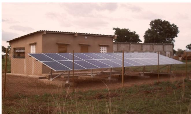
Photo 1 : la centrale de Keur Ndongo avec ses 24 panneaux solaires, son local de stockage de batteries et d'onduleurs. Source : Pierre Robert, 2014.
