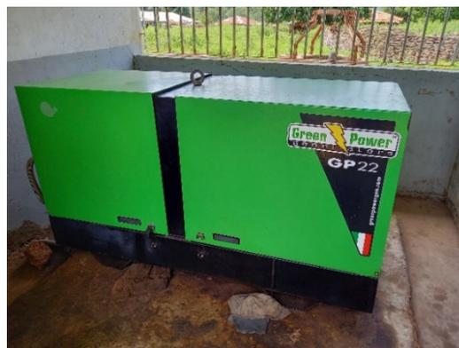
Photo 2 : générateur diesel de la mini-centrale de Keur Ndongo. Source : Emilie Etienne, 2021.
