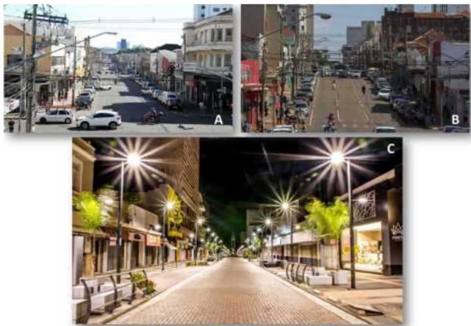
Figura 2 - Vista geral da Rua 14 de Julho: antes (A e B) e depois da requalificação (C).
