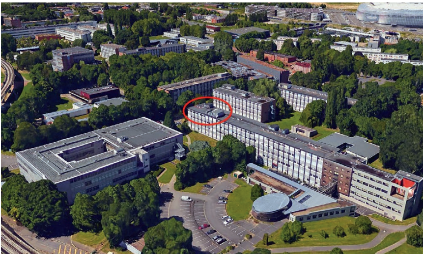
Figure 2. Vue partielle du campus de la cité scientifique (université de Lille). Le LOA occupe le dernier étage du bâtiment longiforme ; le site d'observation atmosphérique est situé sur le toit du laboratoire à l'extrême gauche du bâtiment (entouré en rouge).
